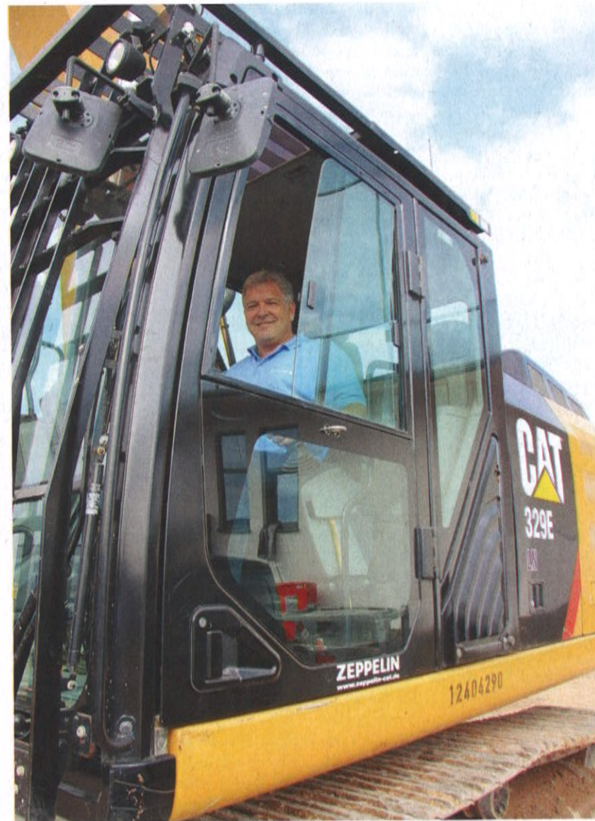
Hier fährt der Chef noch selbst: Peter Norheimer packt bei den Erdarbeiten selbst mit an und steuert die Baumaschinen, wie einen Kettenbagger 329EL, den er für den Bau seines neuen Pharmazentrums gemietet hatte. Fotos: Zeppelin
